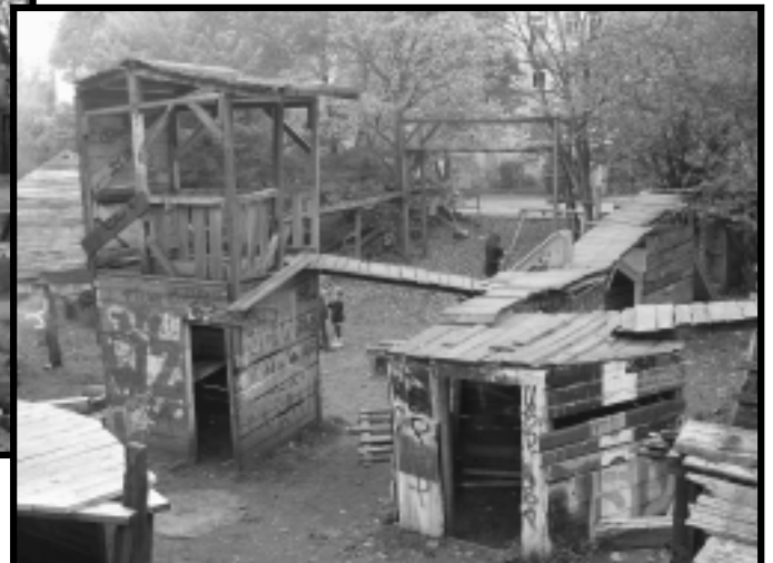
Vue d'ensemble de l'ASP am Brunnenhof
